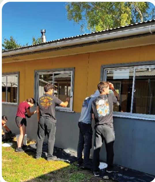
Actividad Cierre CAS 2°EM-4°EM. Construcción en escuela en Carampangue.
