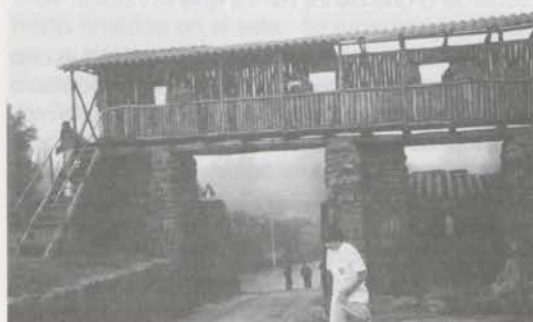
Vista interior de la zona de ingreso al Fuerte de Santa Juana.
